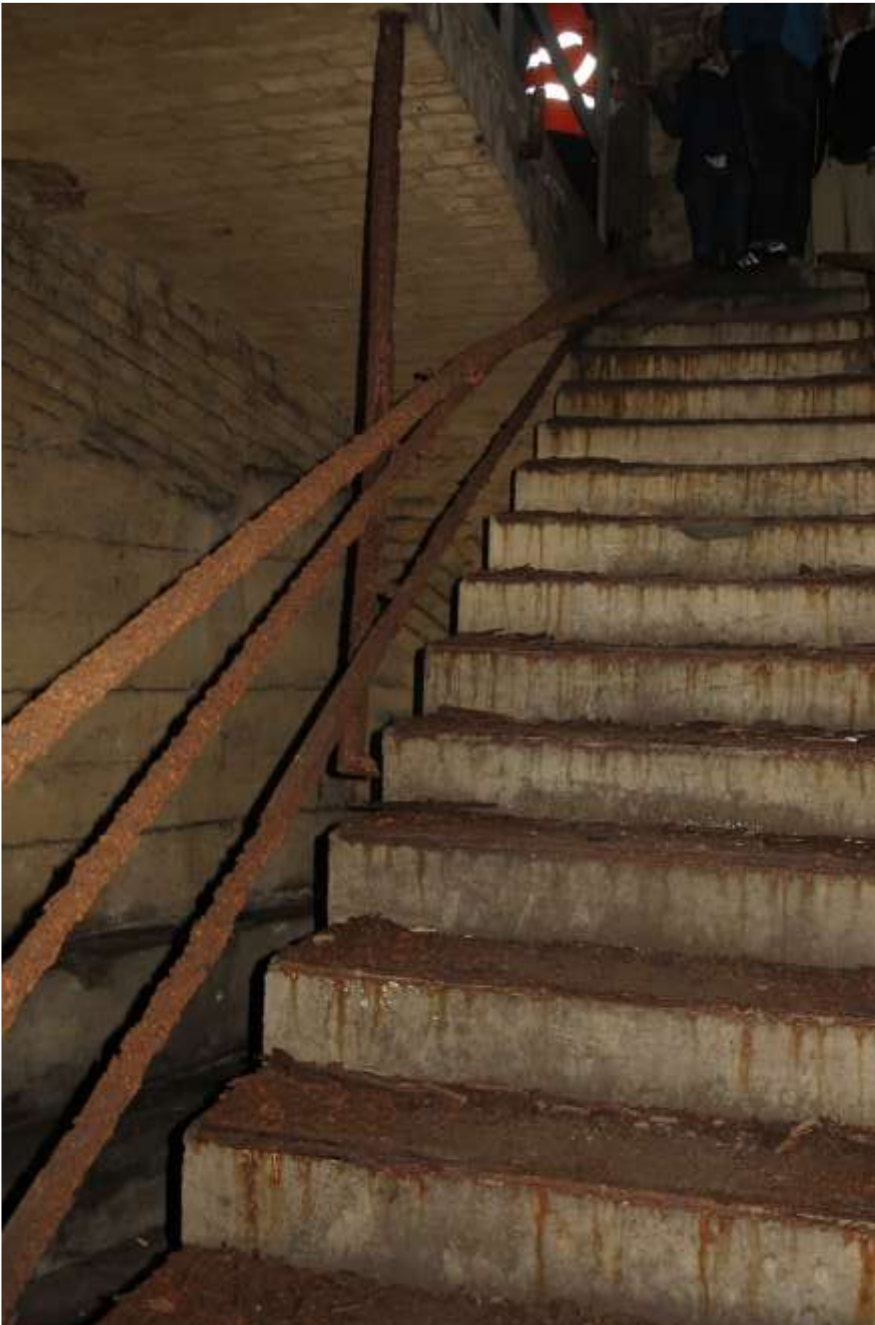
Schadbilder 2015 – Weggerostete Geländer des Bunkereinbaus, eindringendes Regenwasser
