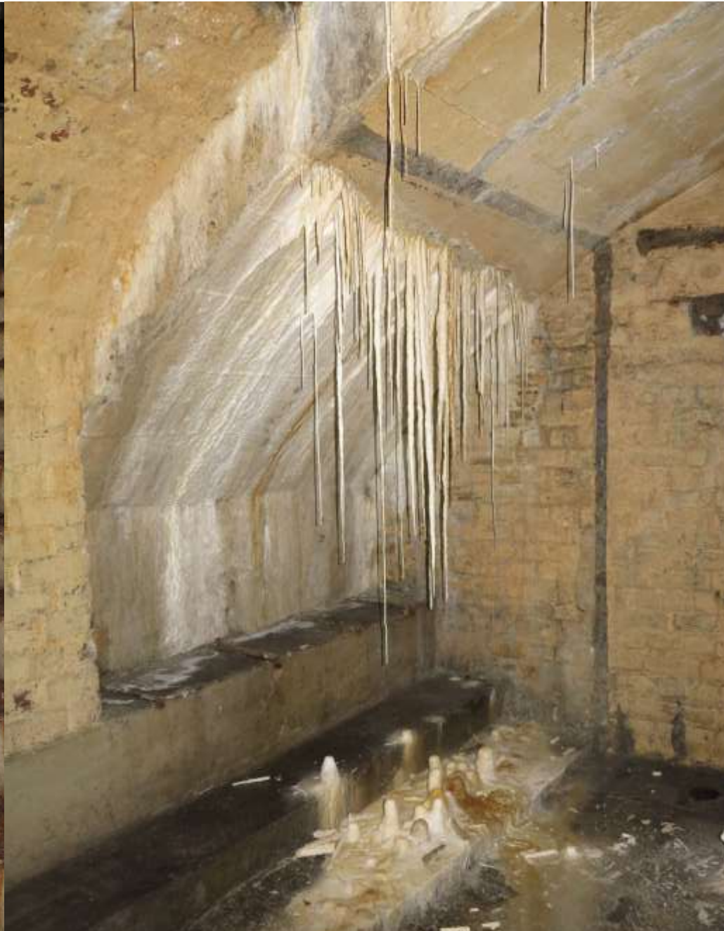
Schadbilder 2015 – Weggerostete Geländer des Bunkereinbaus, eindringendes Regenwasser
